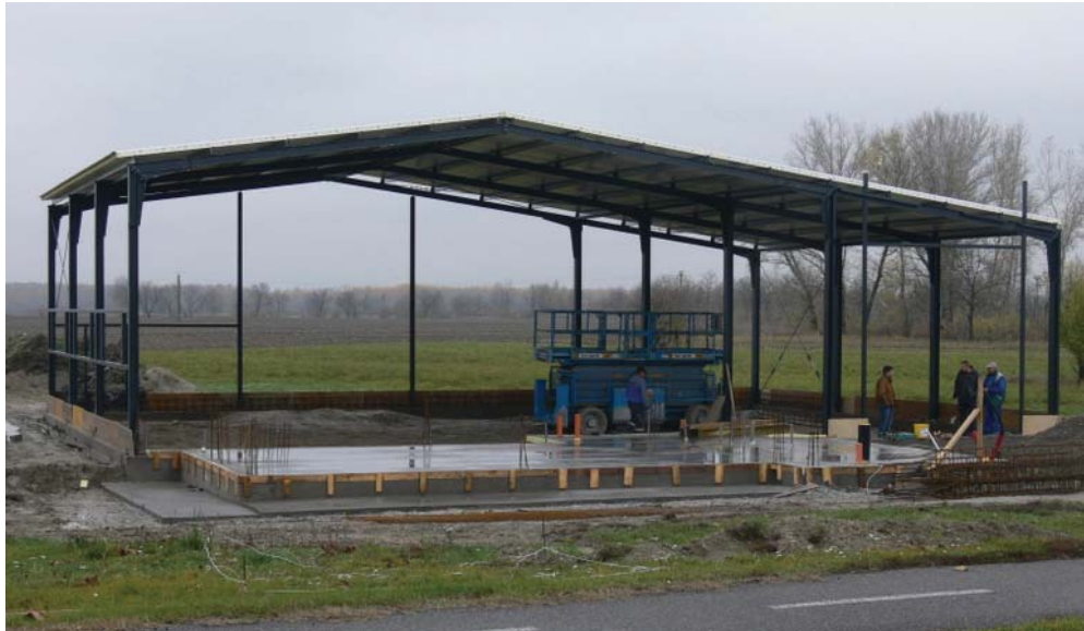
A Geskor Kft. üzemcsarnoka a Fő utcában, a SICK Kft. szomszédságában épül. Fotó: Laczkó Gergely
