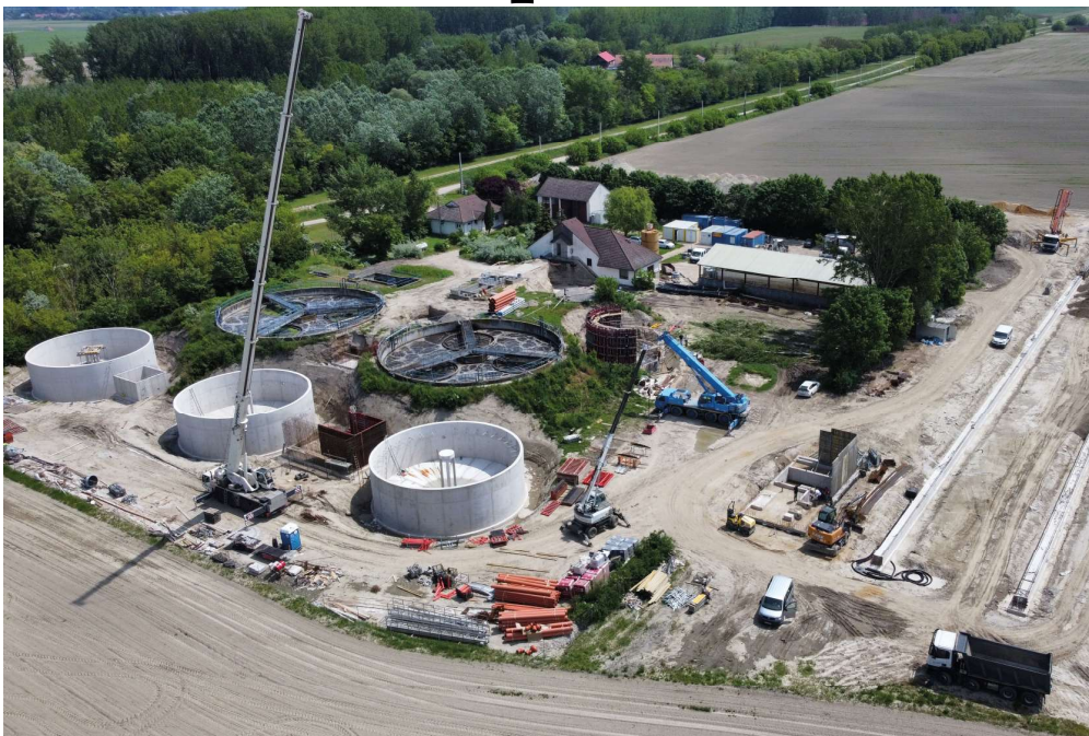
A Kunsziget és térsége szennyvíztisztító telep korszerűsítése 4 milliárd forintos KEHOP-pályázati támogatásból valósul meg. Az építkezés 2024-ben fejeződik be.
